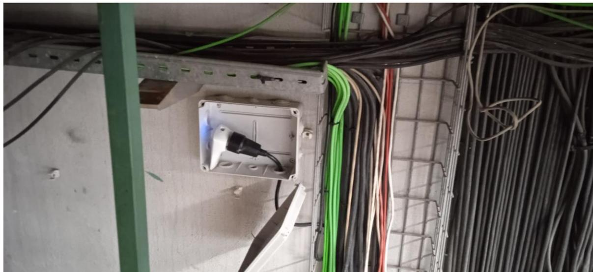
Figura 10: Caja de pared donde está instalado el extensor WiFi
