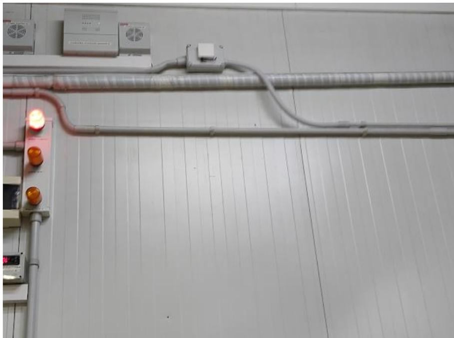
Figura 13: Sensor de temperatura, humedad y CO<sub>2</sub> interiores
