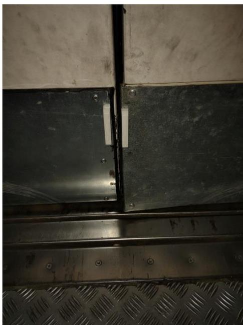
Figura 21: Contacto magnético para detección de apertura de puerta
