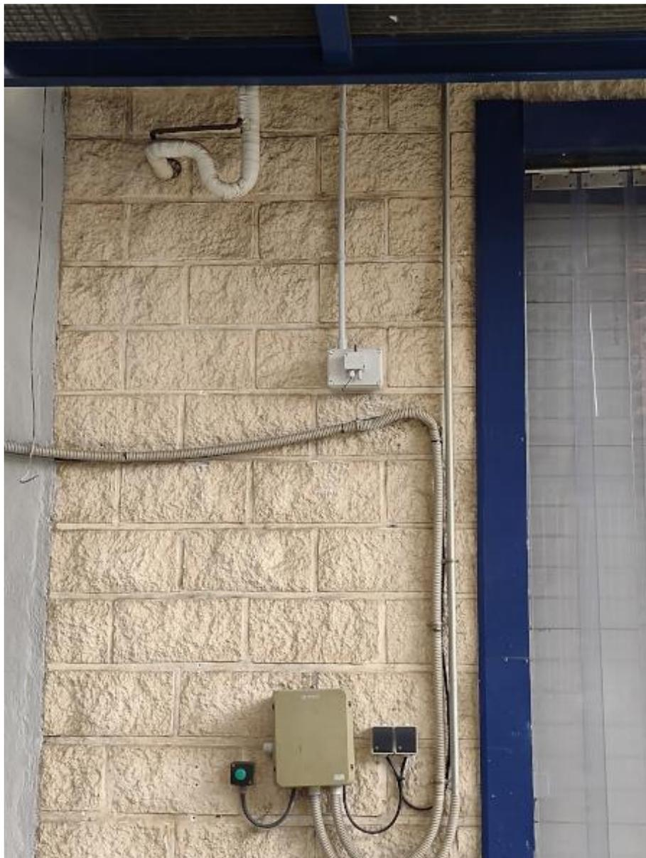
Figura 14: Sensor de temperatura y humedad exteriores
